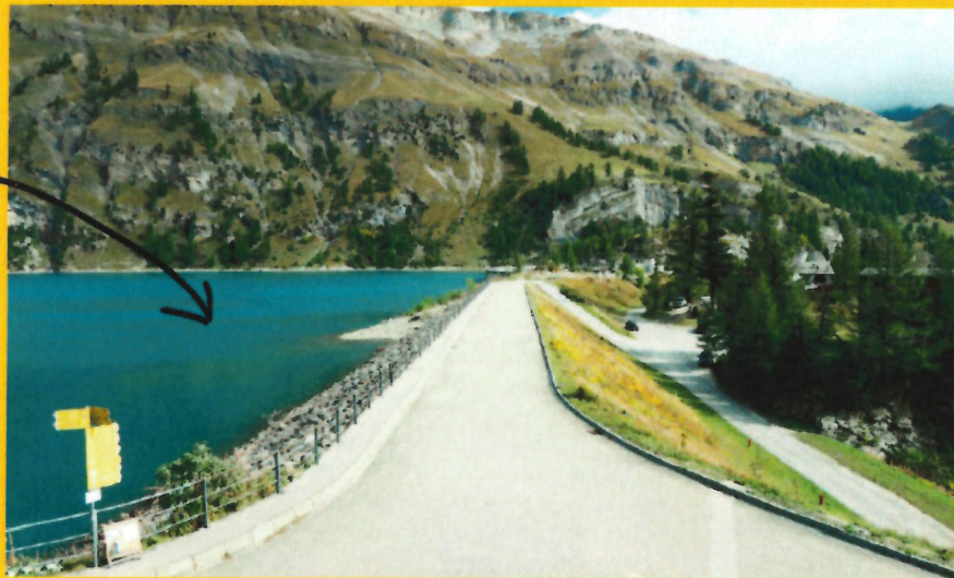
BILD: KRAFTWERK LIENNE (KANTON WALLIS)
